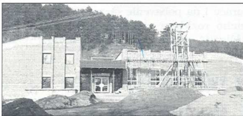
Výstavba kultúrneho domu
