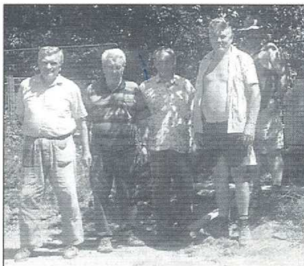
Skupina robotníkov na stavbe kostola
