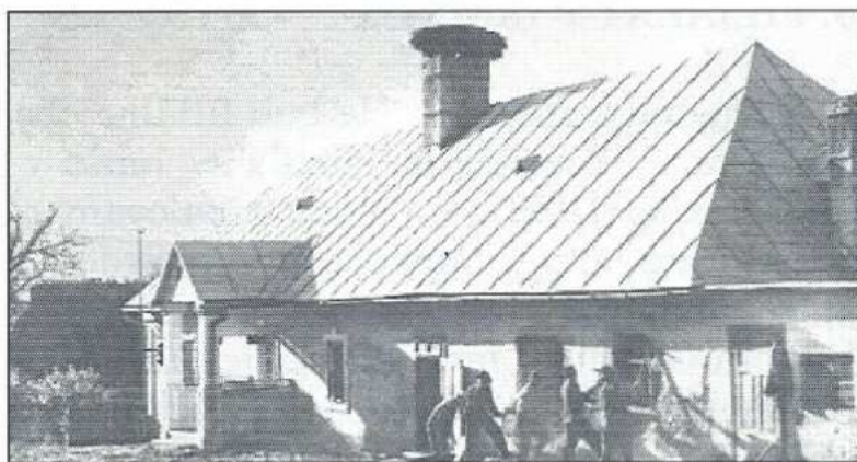
Rekonštrukcia fary v r. 1962
