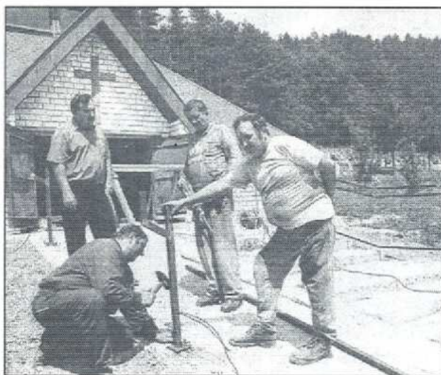
Výstavba domu smútku
